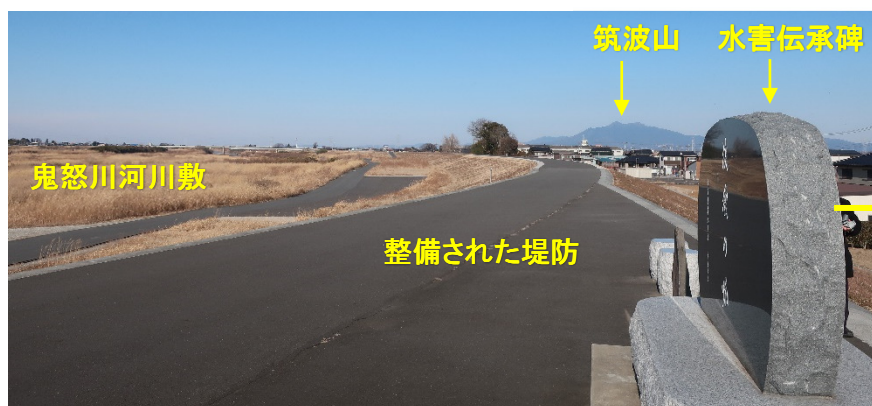
決壊した堤防の復旧状況（北向き）
