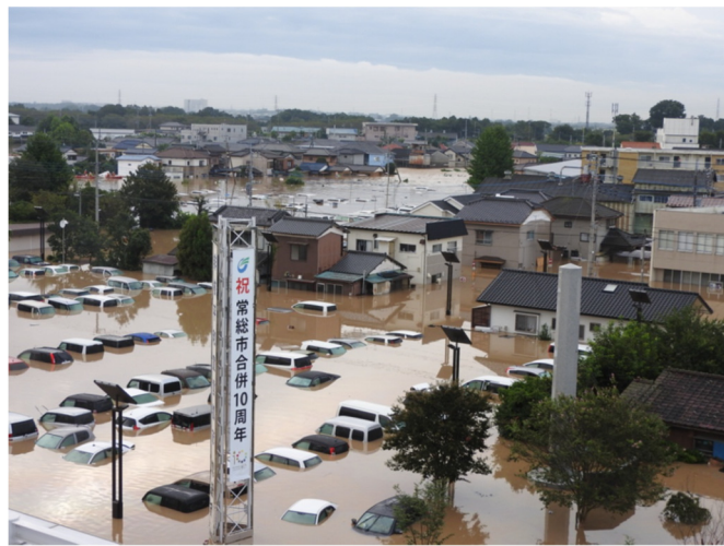
図2 常総市役所周辺での浸水状況(2015.9.11) (4)
