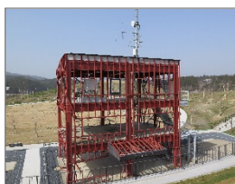
図-4 防災対策庁舎
