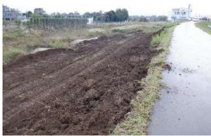
写真5 えぐられた裏のり面
