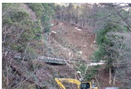
写真 1 箱根の斜面崩壊
