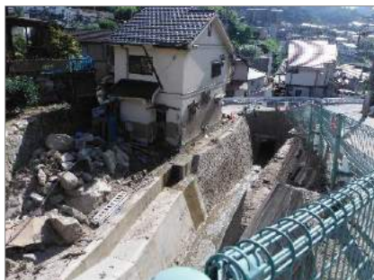
写真1 矢野東の土石流被害
