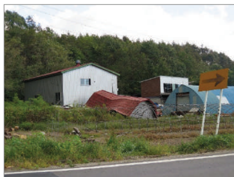
図-3(b) 倒壊した倉庫
