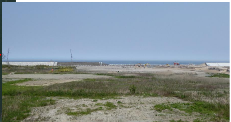
山元海岸：防潮堤整備（標高7.2m）
