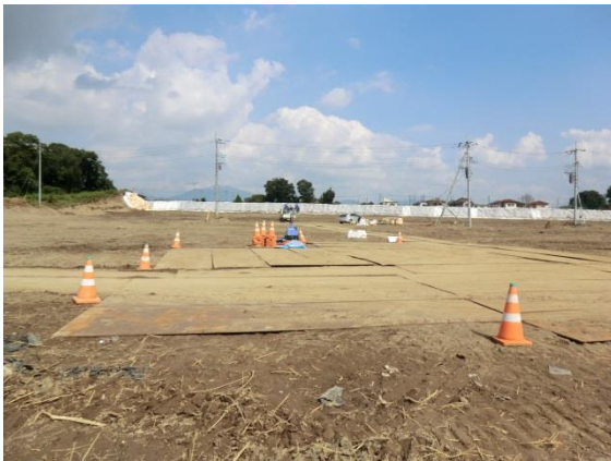
写真-3 決壊した箇所の上流の越水地点
