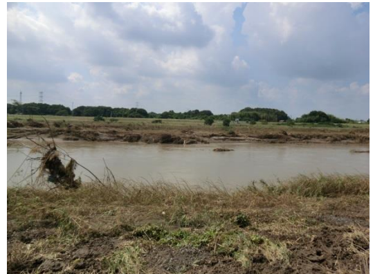
写真-2 決壊した箇所近くの鬼怒川の様子
