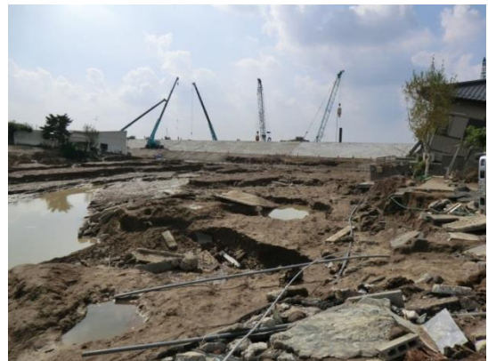
写真-4 決壊した堤防の修復状況
