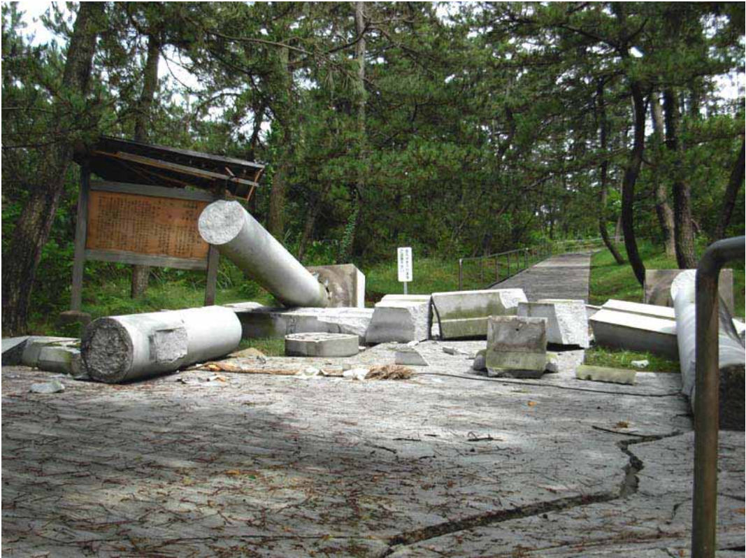
写真 676 青山稲荷神社の鳥居 糸痕が無いので、たて揺れで浮き上がり手前に物が落ちてきたと思われる。
