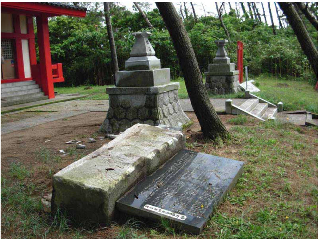
写真 679 青山稲荷神社 同方向に倒れている
