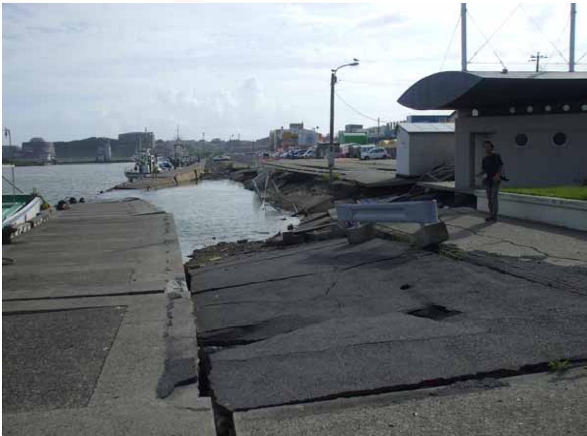
この写真は震災から半年弱の茨城県那珂湊漁港の岸壁の被害状況です。岸壁は約 100m以上に渡り沈下陥没し更に海側に押し出されて海面下まで落ちています。その為に水揚げの船が着岸できない状況です。奥に見えるのが那珂湊魚市場ですが、市場の被害も大きく、再開できたのが震災から半年近くと聞きました。
