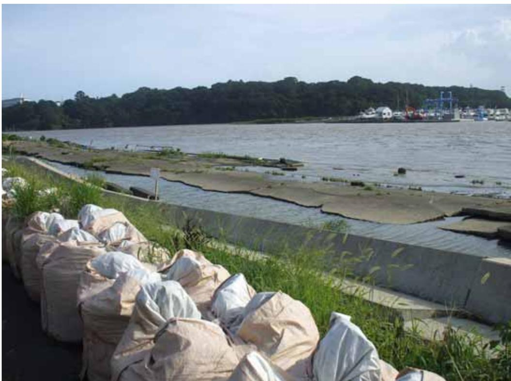
この写真は茨城県大洗町那珂川河口付近の津波による被害状況です。河川敷は小さな舟が着岸できる岸壁になっていましたが、津波で原型を無くしています。
