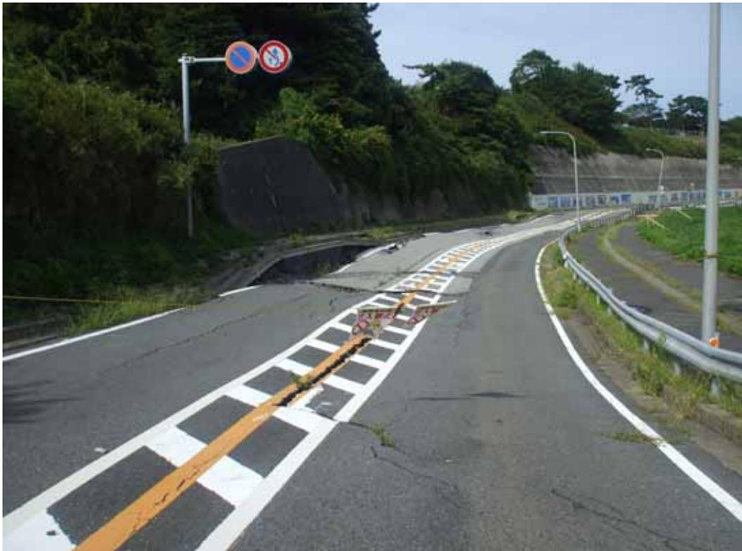
この写真は茨城県那珂湊市和田町の海岸に隣接した道路の被害状況です。浚渫土砂で盛り土をした所に道路が建設されていましたが、液状化、横滑りで、約 1m 程度の陥没といたる所に大きなクラックが発生し、現在も使用不能、通行止め状態にあります。
