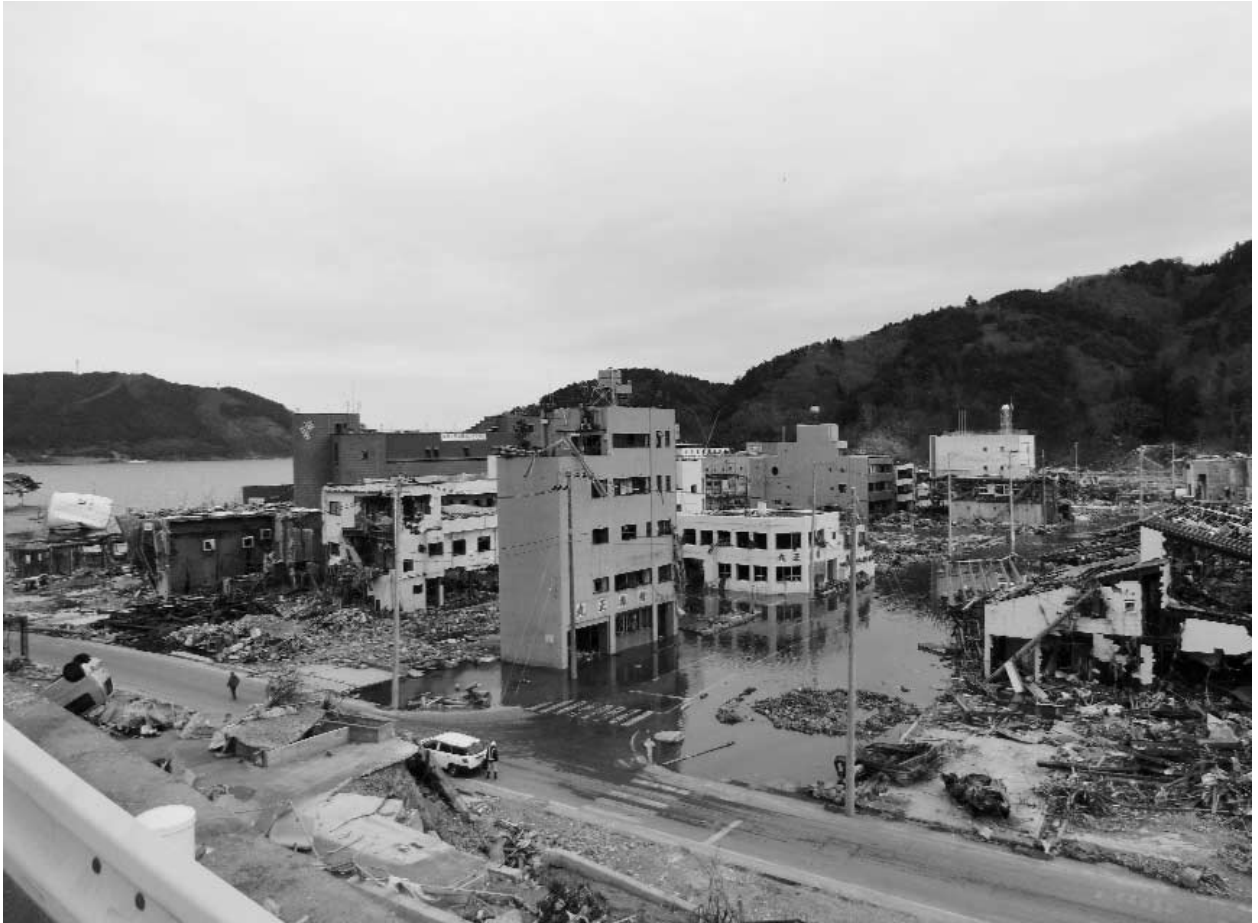
写真2：一旦高台に上がって撮影。既に道路は冠水している。
