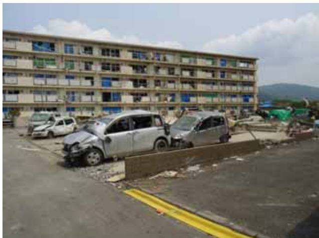
【被災直後】 全戸が被害を被った集合住宅 家の中を突風が吹きぬけ、窓も家の中も 大被害を受けた。
