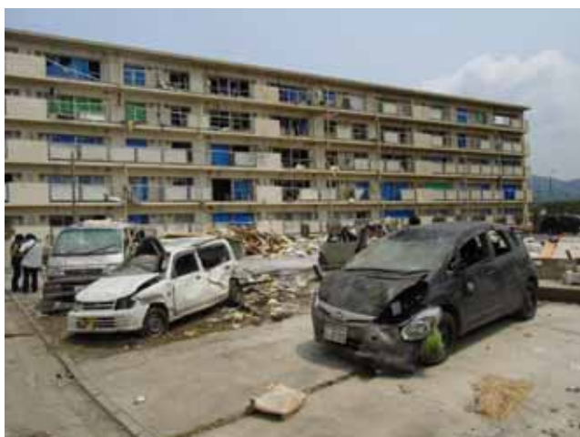
集合住宅前の駐車場では突風で 車が飛ばされた。 また、飛んできた木材でも被害を受けた。
