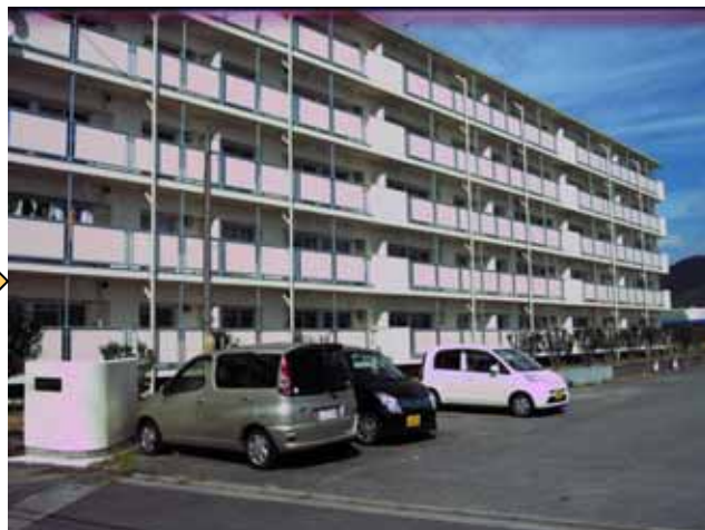
【100日後】 工事用ブルーシートも外れ、 外装、内装とも修復が終わり 再入居間近の状態
