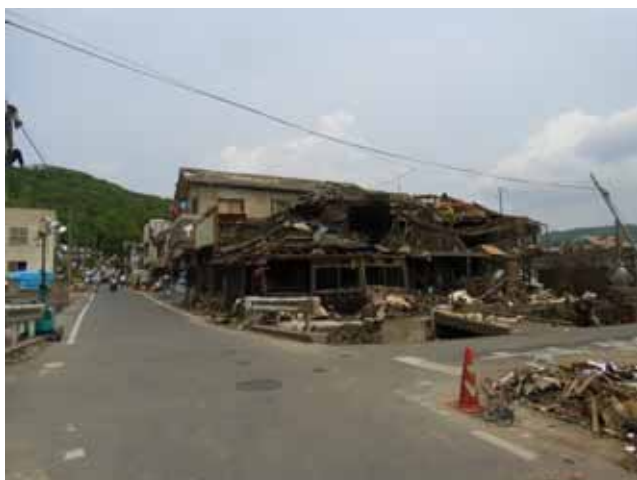
【被災直後】 街の通りにあった食堂 全壊状態である。
