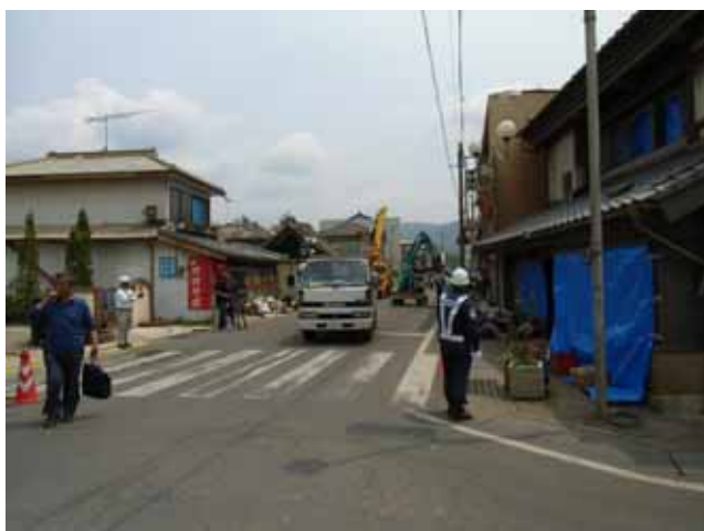
被災後、45時間 復旧作業が始まっている。
